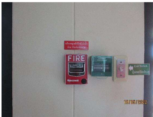
รูปที่ 2-27 การติดตั้งอุปกรณ์แจ้งเหตุฉุกเฉิน
