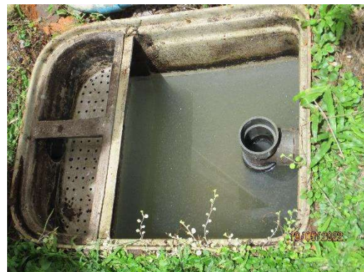
รูปที่ 2-9 ถังดักไขมัน บริเวณด่านเก็บค่าผ่านทางบางบำหรุ
