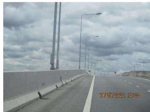
รูปที่ 2-19 กำแพงที่มีความแข็งแรงและมีความสูงเพื่อป้องกันการเกิดอุบัติเหตุ
