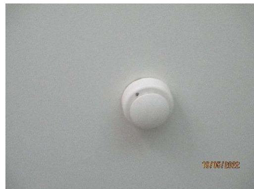
รูปที่ 2-28 อุปกรณ์ตรวจจับควัน (Smoke Detector)
