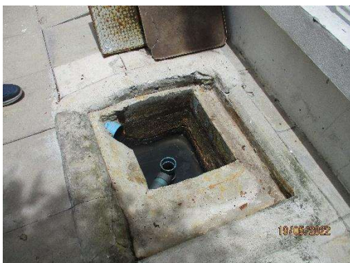
รูปที่ 2-10 ถังดักไขมัน บริเวณด่านเก็บค่าผ่านทางฉิมพลี
