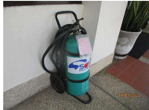
รูปที่ 2-26 ถังดับเพลิงผงเคมีแห้งบริเวณด่านเก็บ ค่าผ่านทาง (Dry Chemical Extinguisher)
